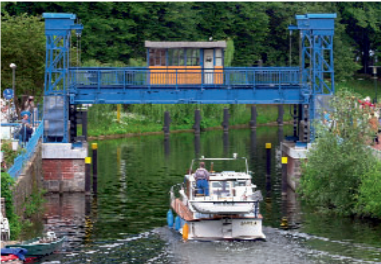
Fluss Elde, Hubbrücke in Plau am See
