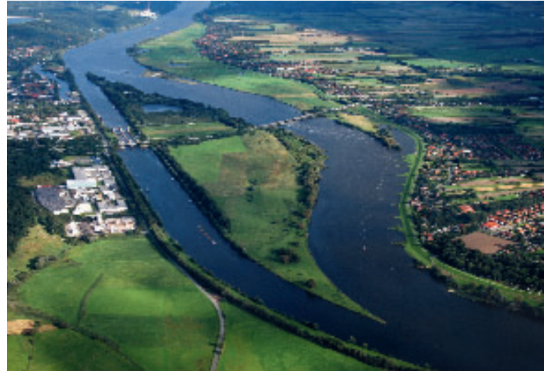
Elbbrücke in Geesthacht, Schleswig-Holstein
